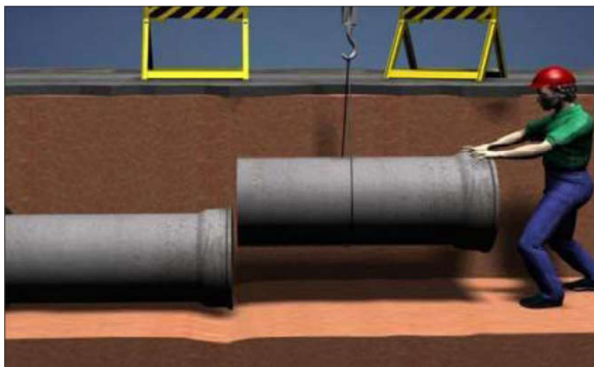
Figura 10 - Acoplamento de tubos de concreto
