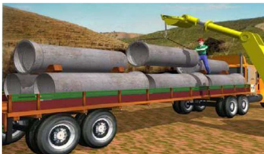
Figura 7 - Descarregamento dos tubos
