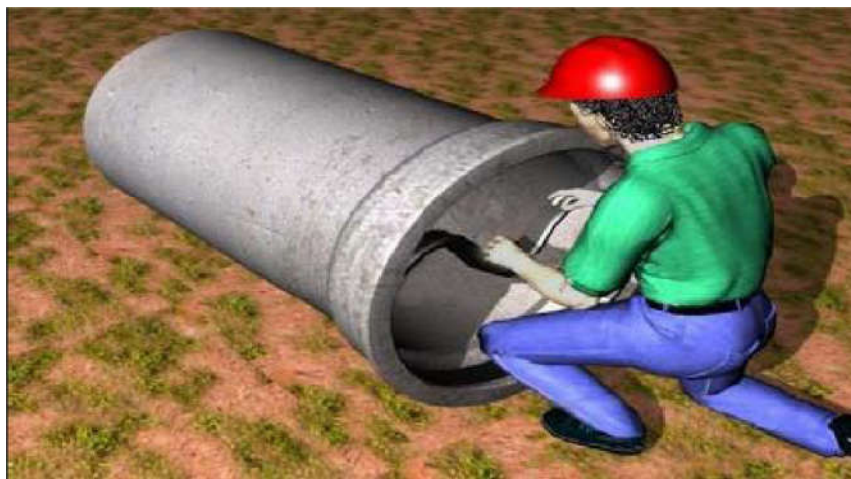
Figura 9 - Colocação do anel de borracha
